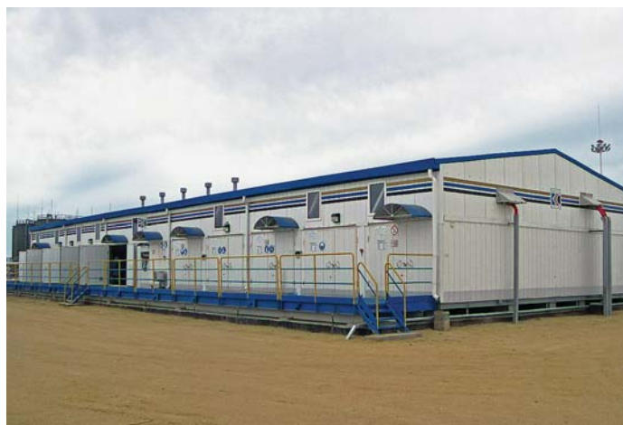
Фото 1. Станция насосная кустовая блочная (БКНС)
